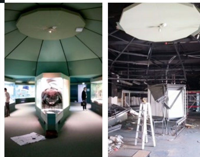
Der Charme der 1970er Jahre muss weichen: Abbruch in Raum 209.
